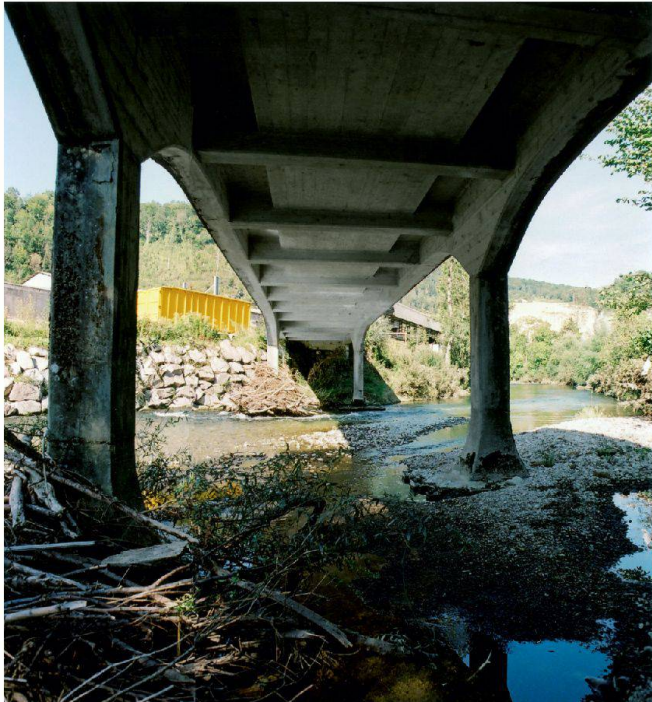
01 Birsbrücke in Liesberg Station von Robert Maillart: heutiger Zustand in der Untersicht. Die 1935 erbaute dreifeldrige Eisenbahnbrücke ist die erste der von Robert Maillart in den Jahren 1935 bis 1939 entworfenen Balkenbrücken mit Kragarmen 1 (Foto: Andreas Naegeli)
