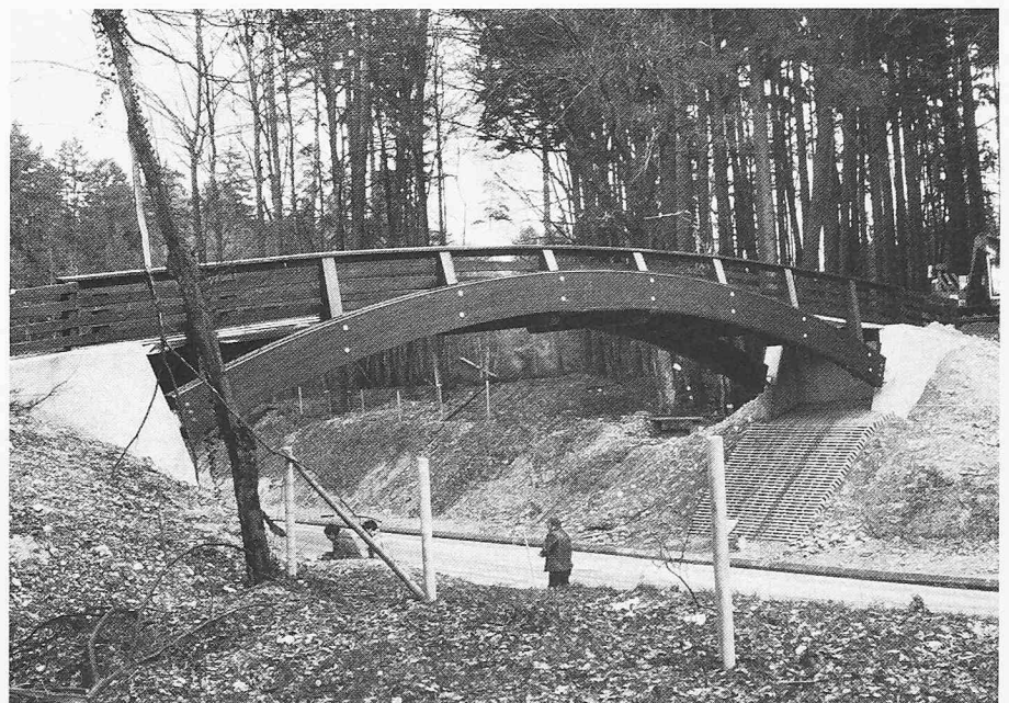
Ansicht der neuen Holzbrücke
