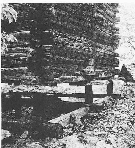
Bild 80. Auf hölzernem Unterbau kommt die offene Zone der Stadelbeine und Tragplatten. Holzstadel aus dem Vispental (Grächenbiel)
