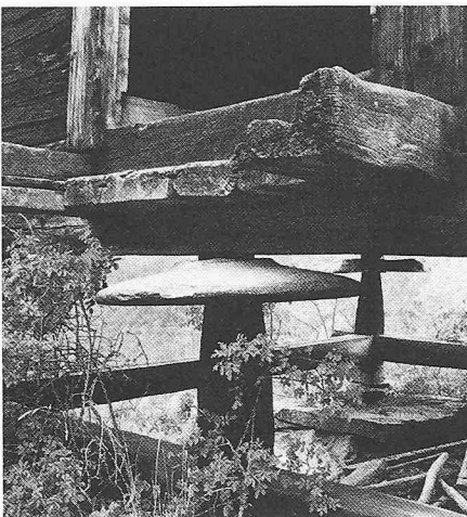
Bild 70. Das Stadelbein, eine mühlesteinartige Gneisplatte gegen Mäuse in Grächen (VS)
