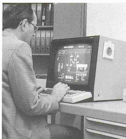
Bild 4. Renato Bernasconi, verantwortlich für Betrieb und Unterhalt sämtlicher haustechnischer Anlagen dieser UBS-Filiale, am Farbmonitor, an dem beliebige Anlageteile und deren Betriebsdaten dargestellt werden können
