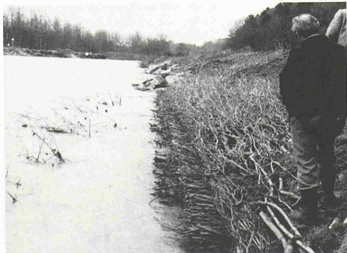
*Rheinuferverbauung bei Diessenhofen. Abtreppung mit Naturbruchsteinen, dazwischen Schroppenlagen mit Weidenstecklingen, die schon ein Jahr nach dem Bau kräftig ausgeschlagen haben*
