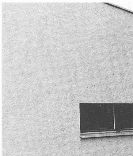
Bild 13. Abgekeellter Verputz, etwas zu eigenwillig die «Handschrift» des Maurers zeigend
