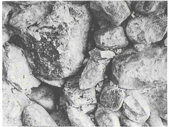
Bild 9. Das Stopfen einer solchen freigelegten Mauerpartie verlangt Geschick und Sorgfalt des Maurers. (Schloss Laupen, Südbau 1986)
