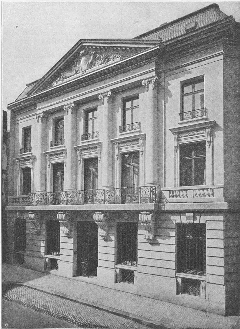
Abb. 5. Fassade an der Freiestrasse.
