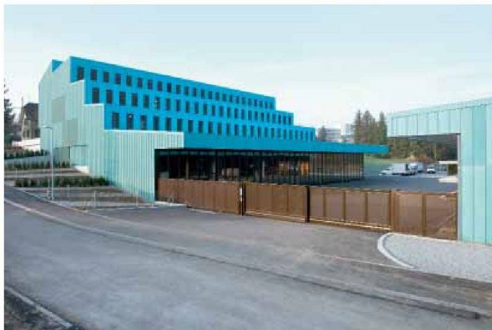
Betriebsgebäude IBB, Brugg
