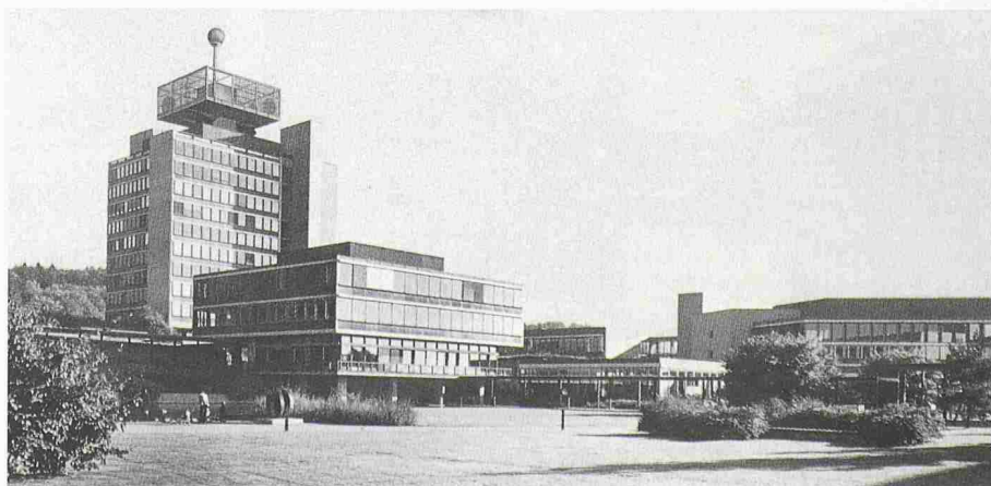
Blick aus einem Gartenhof auf die Unterrichtsbauten v.l. Praktikumbäude mit Antennenanlage, Zentralgebäude, Studentenrestaurant, kleines und grosses Hörsaalgebäude
