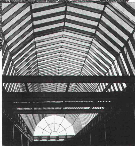
Stahl- und Industriebau
