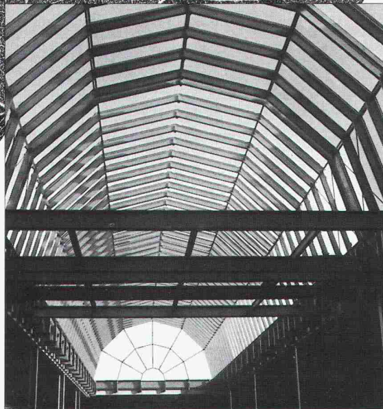
Stahl- und Industriebau
