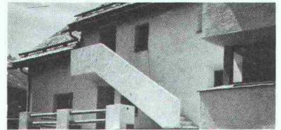
Beispiel einer gelungenen Sanierung eines Altbaues mit Renesco-Thermocrete-Wärmedämmputz (1800 m<sup>2</sup> ü. M.)
