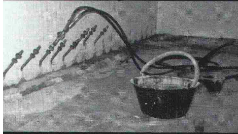
Elastische Abdichtungs-Injektion-Rascoflex in einer Zivilschutzanlage.
