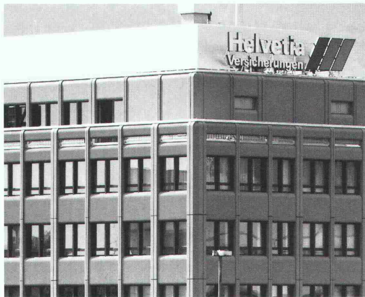
Geschäftshaus Helvetia-Unfall Zürich
