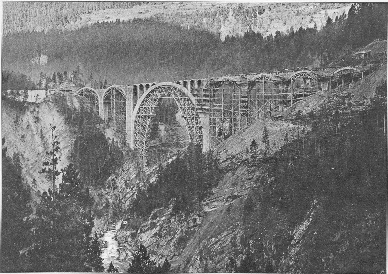
Abb. 23. Gesamtansicht des Wiesener Viadukts von links der Bahn, flussabwärts gesehen.
