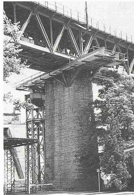
Bild 5. Der Pfeiler auf Seite Wettingen mit fertig installierter Doppelverschubbahn. Abstützung auf Pfeiler und Gerüsturm
