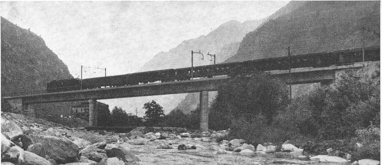
Bild 2. Ansicht der neuen Brücke in Spannbeton
