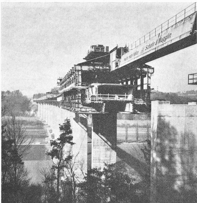
Bild 8 (links). Das Gerüst steht im Feld 13, unmittelbar nach dem Absenken, seitlichen Ausschieben und Hinunterklappen der Schalung. Der hundert Prozent vorgespannte Kastenträger ist bereit zur Aufnahme der grossen Gerüstlasten
