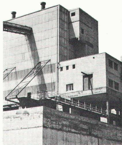
Betonfabriken AEBI bis 200 m<sup>3</sup> und mehr Festbeton pro Stunde.
