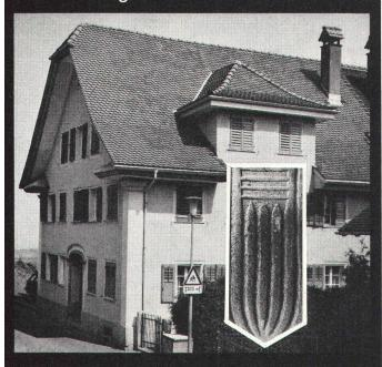
Der «Biber alt» ist ein rustikaler Tondachziegel, der in allen Teilen der Spitzenqualität moderner Ziegel entspricht, aber in Form und Farbe dem früheren Handziegel gleicht. So hat er beispielsweise eine «handgestrichene» Oberfläche und erhält vor dem Brennen seine unregelmässige Farbe. Dieser Ziegel eignet sich speziell für die stilgerechte Restauration erhaltenswerter Gebäude.
