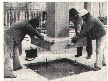
Hohe Gebäude mit schweren Deckennutzlasten verlangen schwere Stützen. Stützen-Montage für das Fernbetriebszentrum der PTT-Betriebe in Zürich-Herdern.
