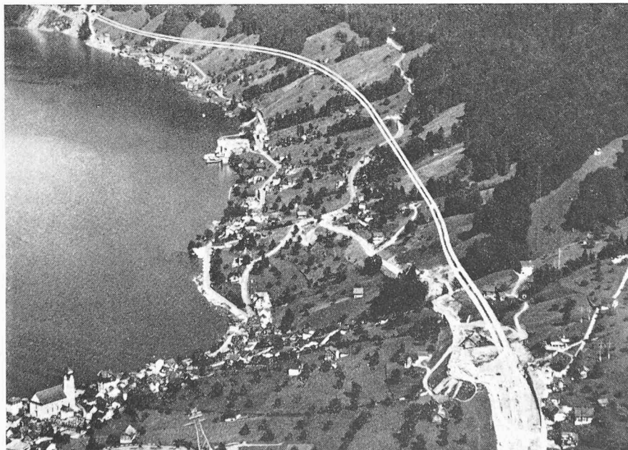
Bild 1. Photoaufnahme des Geländes mit eingezeichneter Linienführung der N 2 im Bereich des Lehnenviaduktes vom Widerlager West unter der Seilbahn Klewenalp bis zu den Tunnelportalen des Seelisbergtunnels (Aufnahme: A. Odermatt, Stans)
