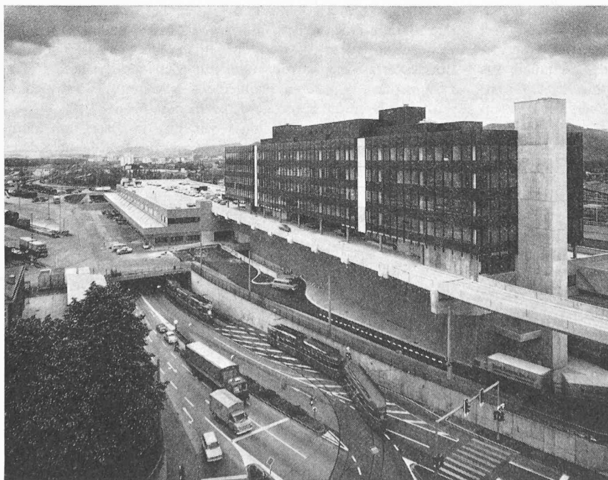
Ansicht Nord-West. Überdeckung St. Jakobs-Strasse. Auffahrt für Personenwagen. Auffahrtrampe für Personenwagen zum Parkplatz
