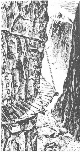
«Die an Ketten aufgehängte Twärrenbrücke» des 13. Jahrhunderts. 500 Jahre später durch das «Urner Loch» unnötig geworden. Zeichnung von R. Sager, aus «Bauen in der Schweiz – 75 Jahre Schweiz. Baumeisterverband», 1972
