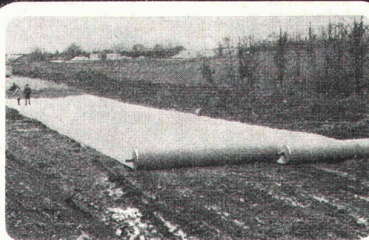
Abrollen der Matte, Vorkopf- aufschüttung
