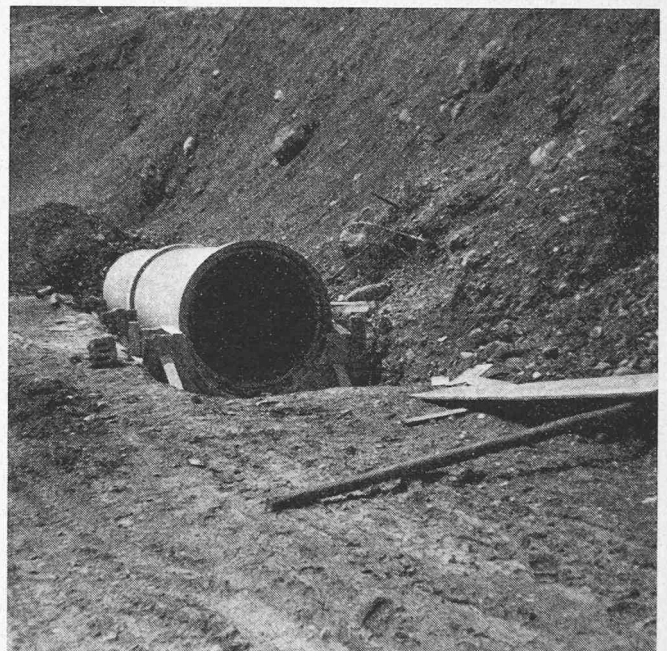
Bild 6. Feldversuch, Ansicht vor Einfüllen
