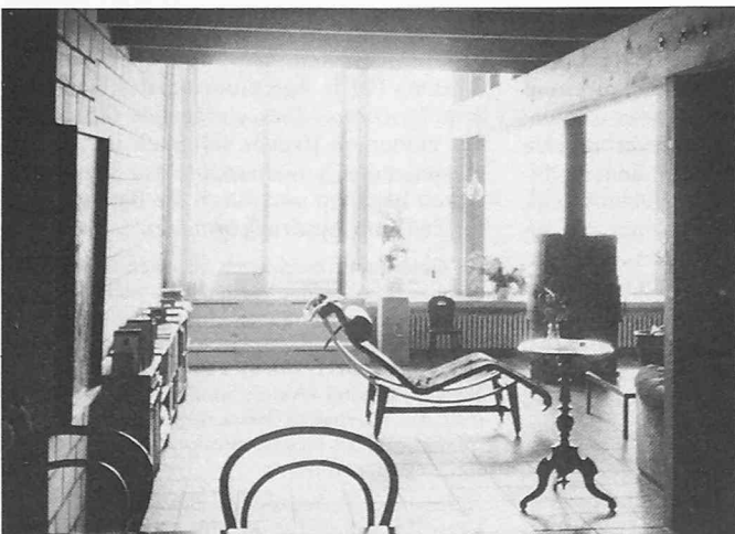
Das nach Süden aufsteigende Doppelpultdach und die gestuften Böden ermöglichen im Winter eine tiefe Durchsonnung des ganzen Gebäudes
