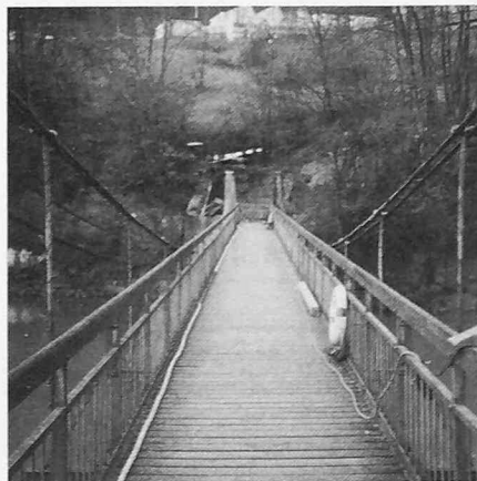
Längsansicht des alten Steges
