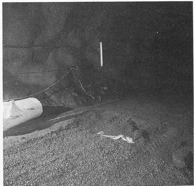
Bild 18. Bahnunterbau. Filterkies und Mitteldrainage. Eingewalztes, zementstabilisiertes Ausbruchsmaterial
