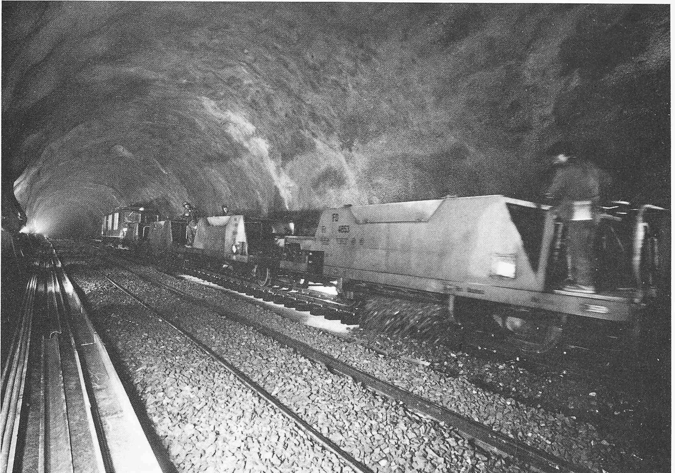
Bild 19. Schotterzug in der Kreuzungsstelle Tunnelstation Rotondo
