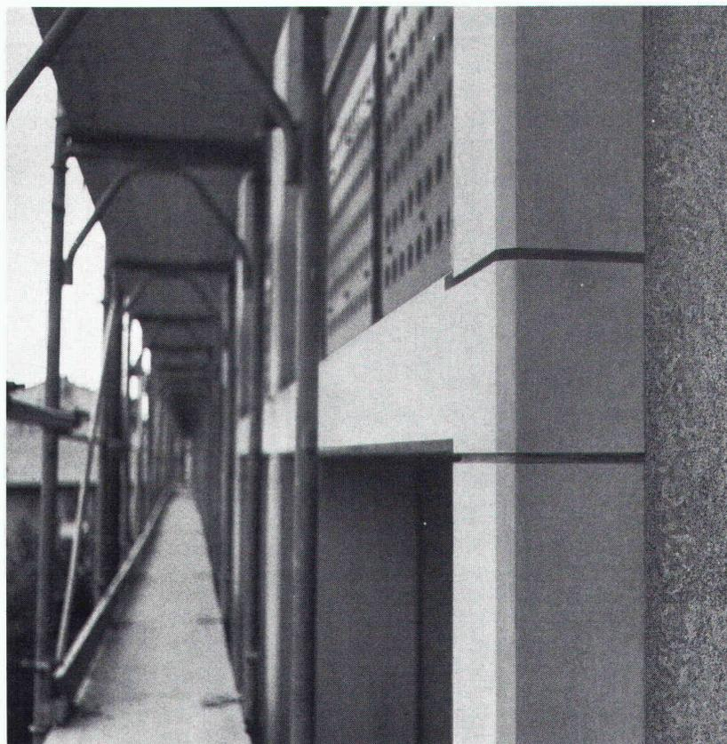
Karbonatisierungsgrad untersuchen, zerstörte Betonteile ausspitzen, Risse injizieren und Armierung schützen.
