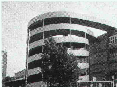
Rampe Parkhaus Migros Herdern
