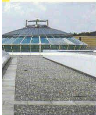
Umbau Einkaufszentrum Glatt. Mit Sarnafil T.
