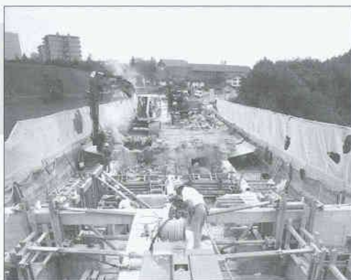
Sanierung und Verbreiterung der Pérolles-Brücke, Freiburg
