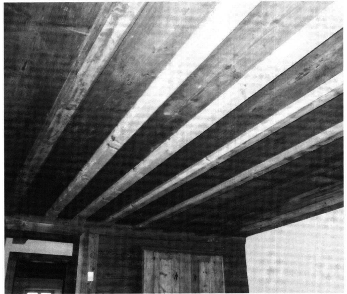
Abb. 8: Altendorf, Haus Steinegger, Hafenweg 2. Von der Holzdecke der Stube im 1577 geschaffenen Hausteil waren genügend Elemente vorhanden, dass sie wiederhergestellt werden konnte. Die Decke war allerdings derart geschwächt, dass sie auf einen neuen Träger montiert werden musste.
