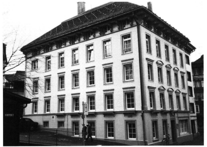
Abb. 13: Einsiedeln, Haus Raben, Schwanenstrasse 42. Das städtisch anmutende Gebäude ist mit Ausnahme des Mauersockels in Holz errichtet, farblich jedoch einem Steinbau angeglichen.
