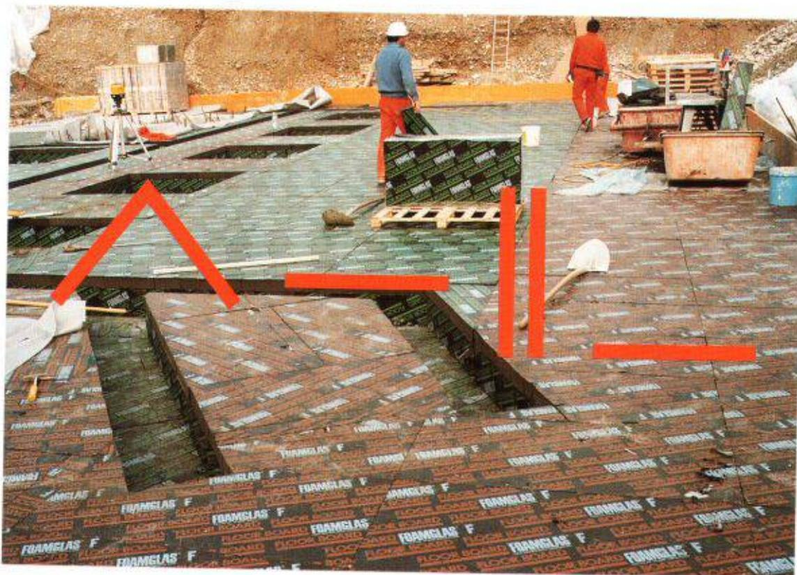
FOAMGLAS®-FLOOR BOARD, eine Weiterentwicklung von Pittsburgh Corning für die Bodendämmung in Trockenbauweise (im Bild die in Abhängigkeit der erwarteten Belastungen gemischte Verlegung von FOAMGLAS®-FLOOR BOARD und FOAMGLAS®-FLOOR BOARD F unter der Gründungsplatte eines Industriebaus).
