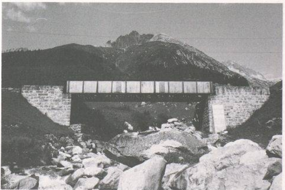
Bild 4. Alte, zu ersetzende Stahlbrücke
