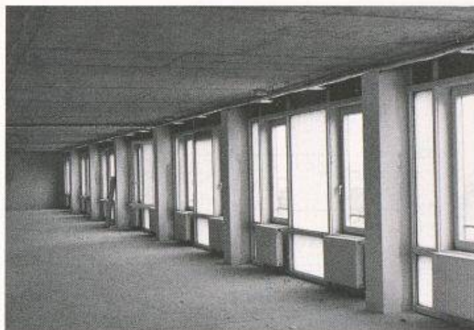
Bild 6. Transparente Isolation zur Tageslichtnutzung im Technologiepark Düsseldorf
