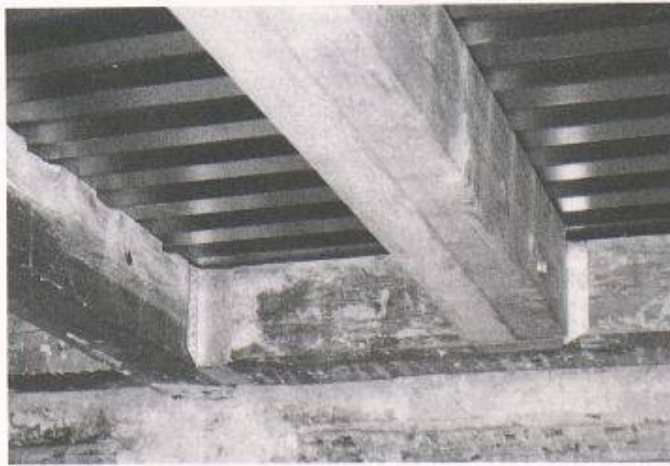
Bild 3. Holzbalken und Trapezbleche von unten gesehen
