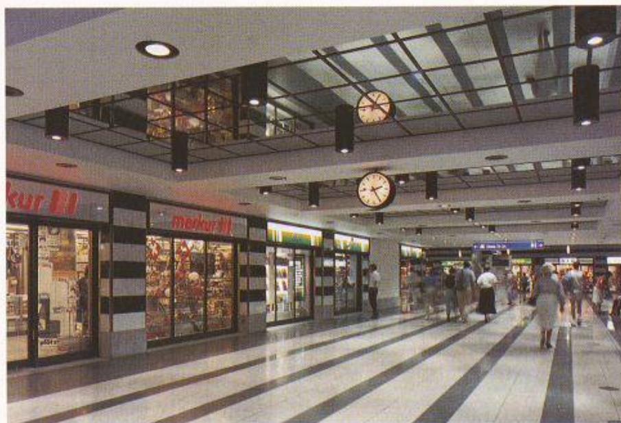
Bild 6. Passage Löwenstrasse mit Pinhole-Spiegelleuchten
