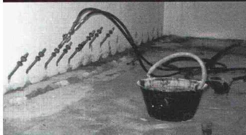
Elastische Abdichtungs-Injektion-Rascoflex in einer Zivilschutzanlage.
