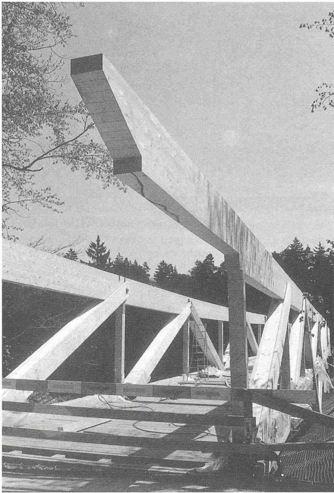
Bild 5. Eines der vier auskragenden Obergurtenden mit je einer Kragarmlänge von 2,2 bzw. 4,4 m
