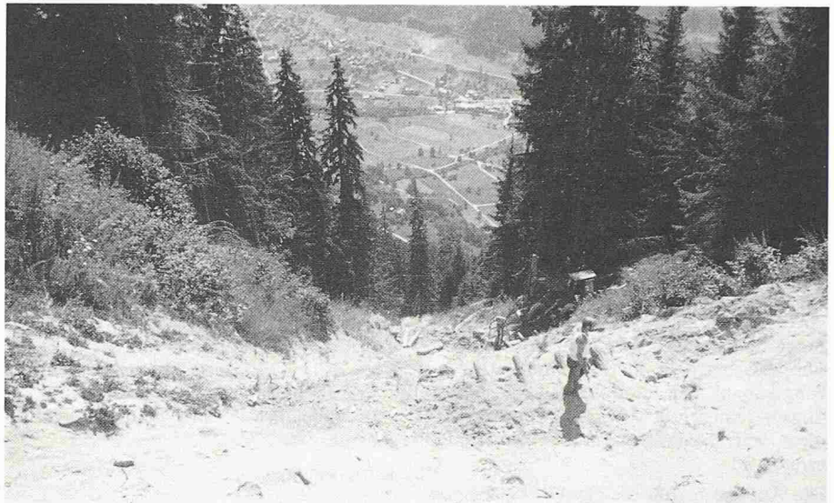
Fast die Hälfte der Bundesbeiträge für die Waldförderung ging 1987 in die Bereiche Verbauungen und Aufforstungen. Häufig sind besonders im Berggebiet dringende Notmassnahmen erforderlich
