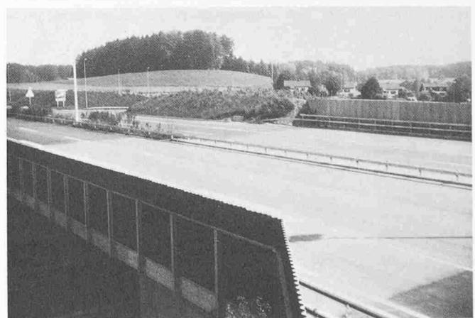
Bild 7. Brücke mit Schutzwänden und Erdwälle an der Umfahrung Rütli
