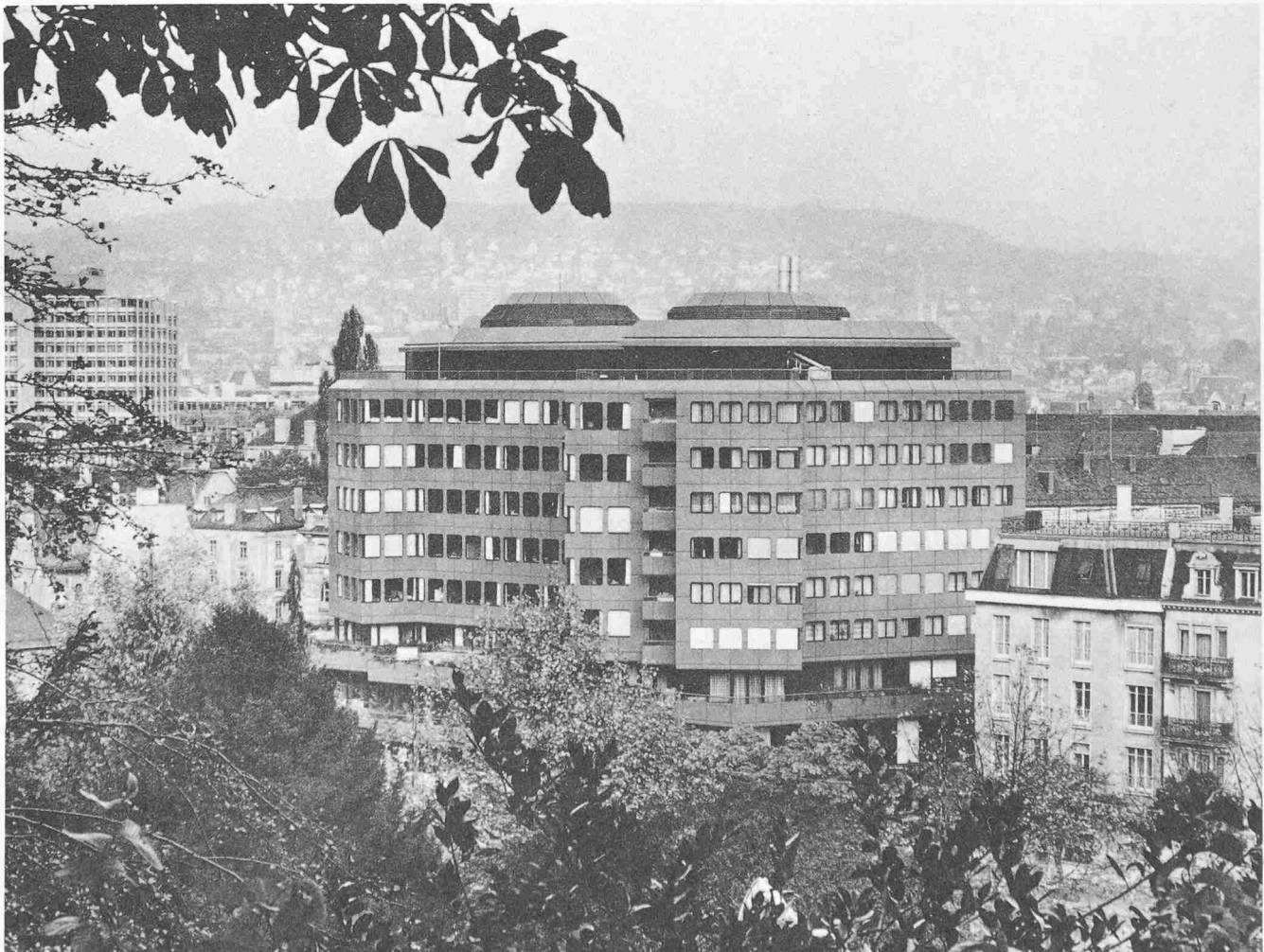
Das «Haus zur Enge», Südwestansicht vom Kirchhügel Enge
