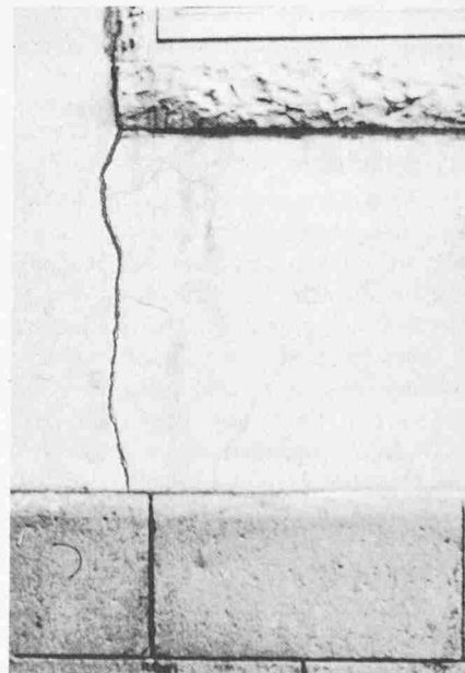
Bild 5. Thermische Risse
