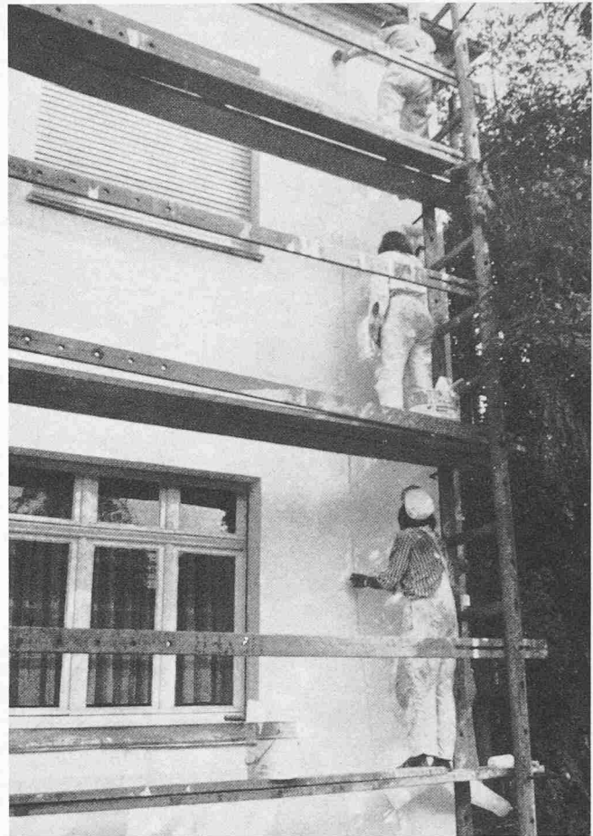
Bild 6. Einlegen des Elastic-Gewebes in den Armierungskleber
