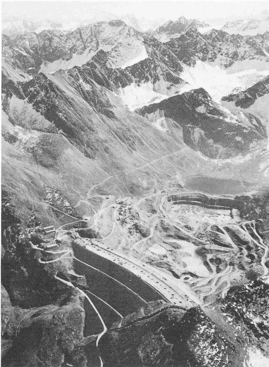
Bild 8. Staudamm für den Speicher Finstertal (60 Mio m 3 ; 2325 m ü. M.) für die Oberstufe der Kraftwerkgruppe Sellrain-Silz. Ende 1979
