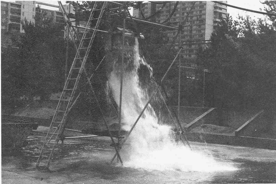
Bild 12. Spülkippe* beim Entleeren. Fallhöhe: 2,00 m.
