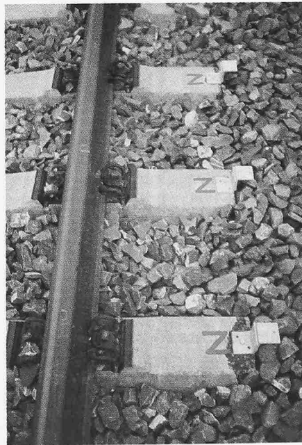
Bild 4. Messpunkte für Einsenkungsmessung
