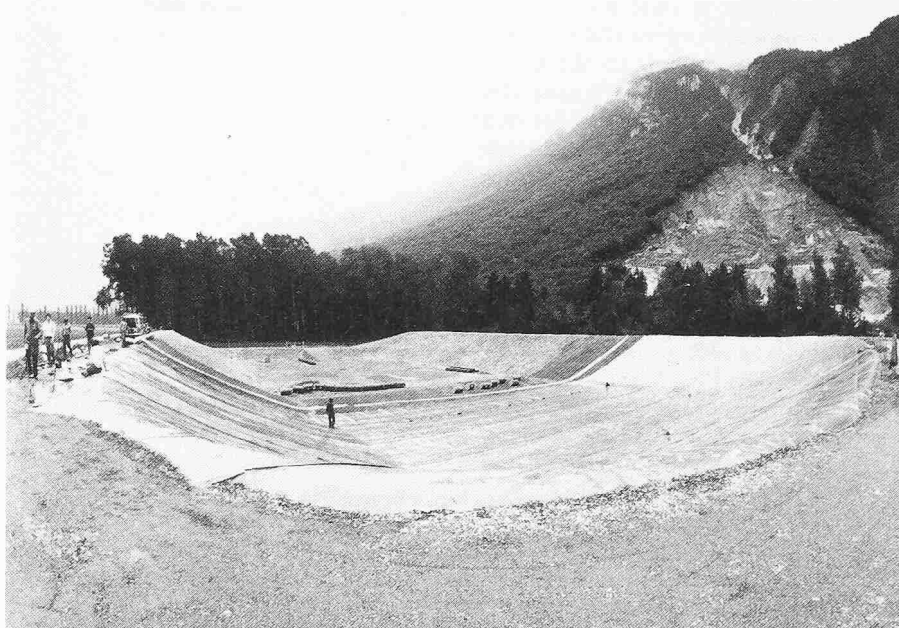
Bild 11. Blick auf die mit Kunststoffdichtungsbahnen fertig abgedichtete erste Etappe der gesicherten Deponie in Collombey-Muraz
