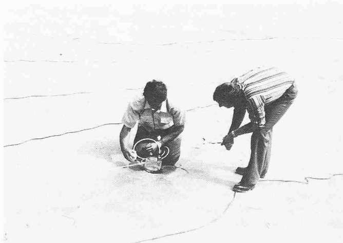
Bild 8. Prüfung eines über einer undichten Stelle aufextrudierten KDB-Stückes mit dem Vakuumprüfapparat
