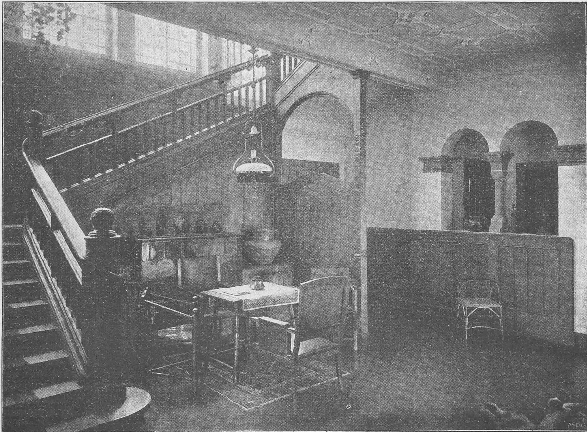
Abb. 9. Blick in die Halle gegen den Vorraum und die Treppe zum Obergeschoss.
