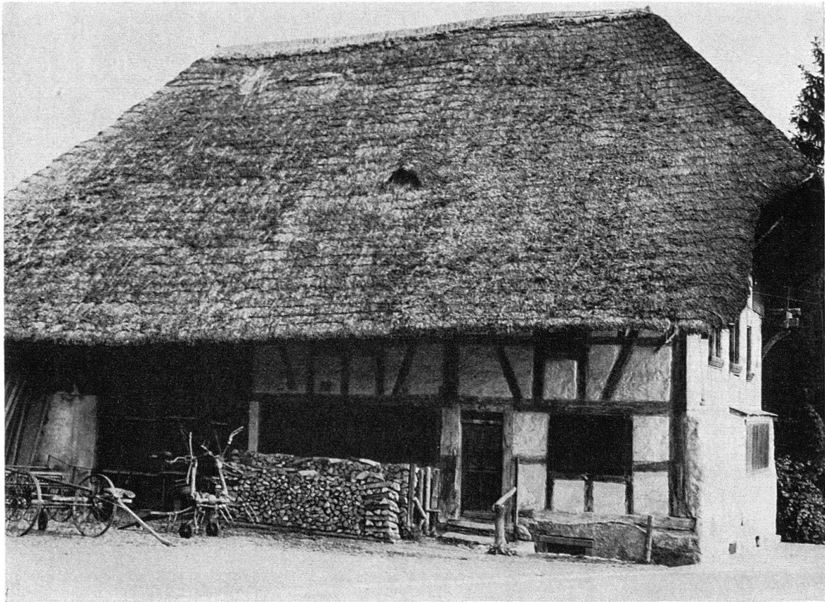
Abb. 2. Einziges noch mit Stroh bedecktes Walmdachhaus nördlich der Limmat, heute unter Heimatschutz. Rückwärtige Wand teilweise Bohlenständer, Wohnteil in Fachwerk. Hüttikon ZH, 1652
